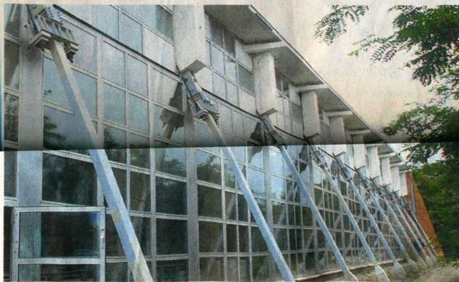
Die alte Schwimmhalle am Brauhausberg. Eine Variante wäre ihre Sanierung
