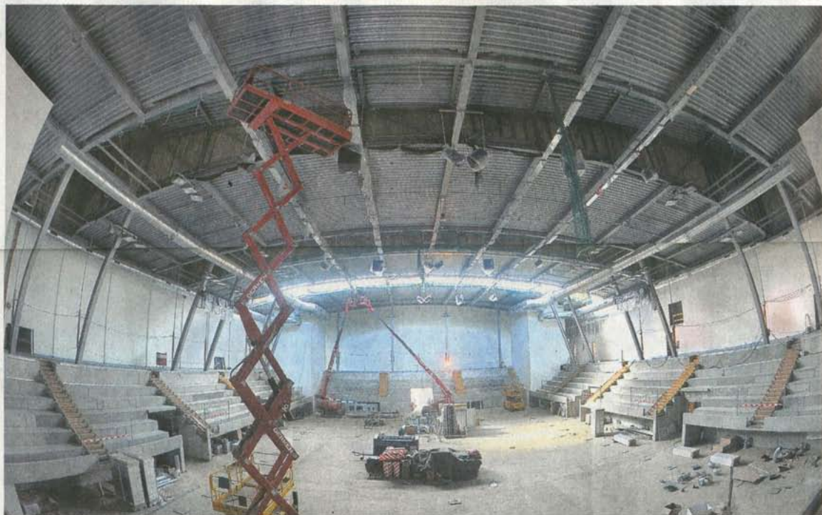
Blick in die künftig 2000 Zuschauer fassende Haupthalle. Die Lautsprecher hängen schon unterm Dach.
